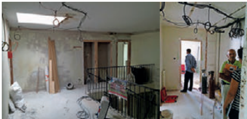
Le palier du dernier étage après désamiantage
